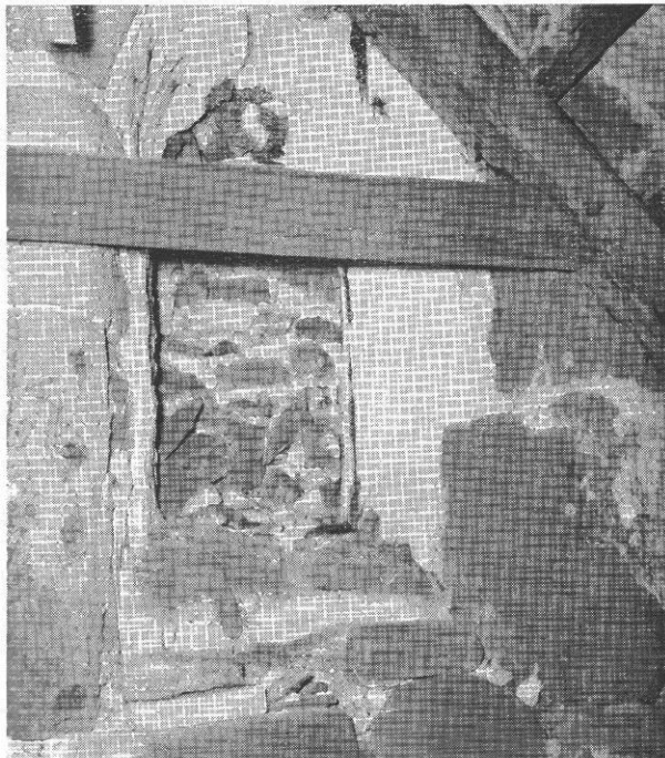
På våbenhusets loft: et af de oprindelige vinduer — med trærammen bevaret — i Højby kirkes ældste del.
