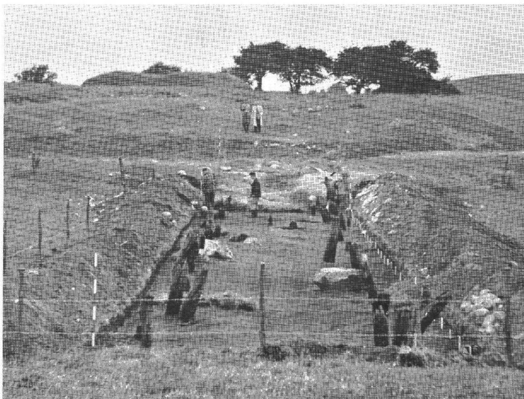
Pælebroen, da dens rester under udgravningen var blottet. Hvor de to personer står, førte forbi brovagtens hus en brolagt vej op over det af vand omgivne borgteræn. Til venstre ruinerne af fæstningstårnet.
